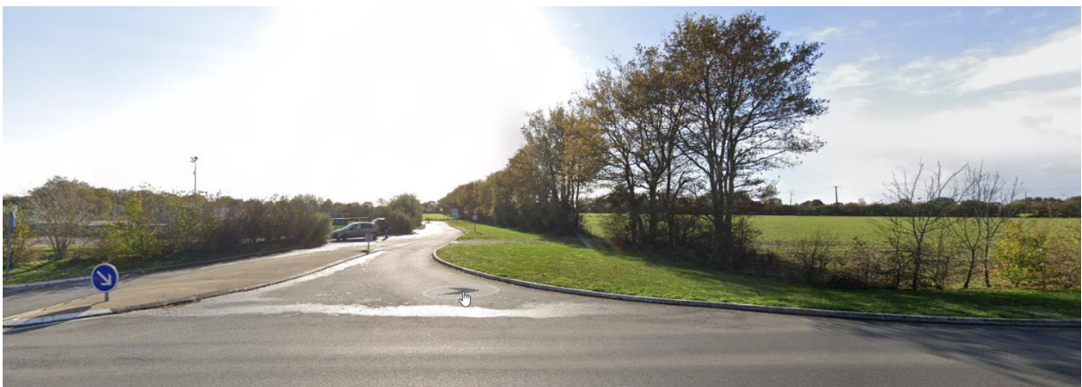
Vue de l'accès au site par la RD 16 ainsi que l'accès à la déchetterie existante
